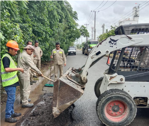
Utilización de asfalto frio sostenible para el mantenimiento vial
