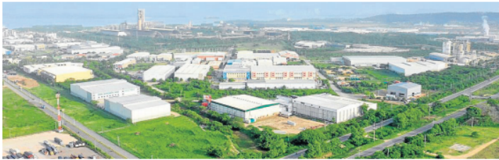
Instalaciones de Zona Franca La Candelaria (ZFLC).
