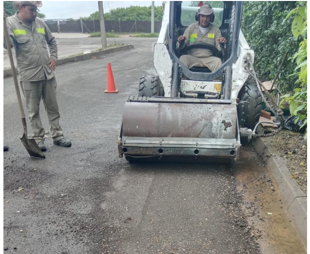
Utilización de asfalto frio sostenible para el mantenimiento vial
